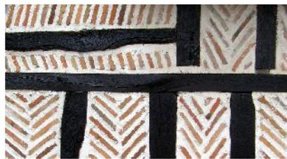
Les hourdis seront restaurés à l'identique : torchis avec enduit au mortier de chaux, *chanignole\** posée au mortier de chaux (joints au *nu\** du mur).
